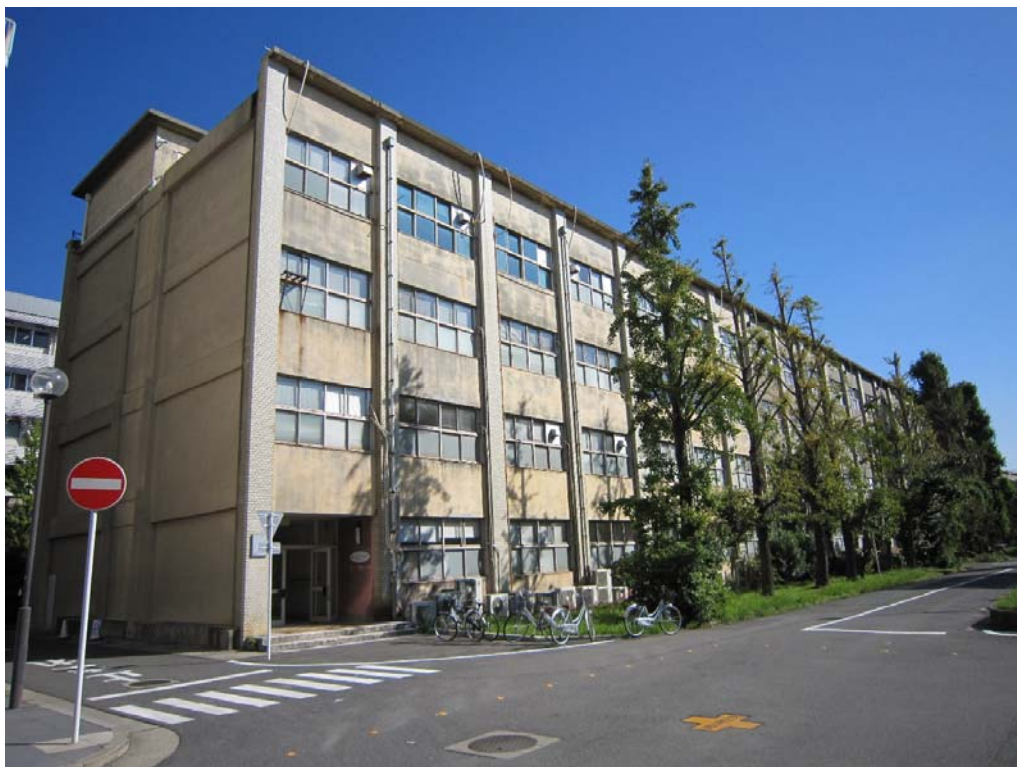
現在の旧計測棟。入り口より西側が 取り壊された。
