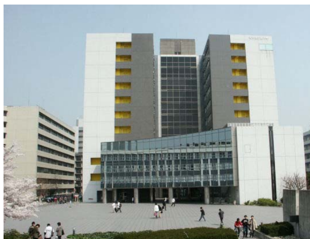
2 号館をニュートンリングの上から望む。向かって左側が A 棟、右側が B 棟 (計測物理系プログラムの研究室の多くが入っている)。
